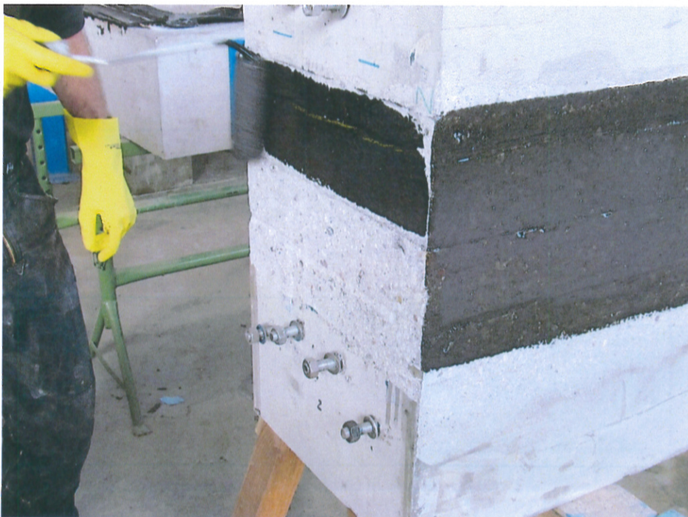
Bild 2 Auftrag der Grundierung
