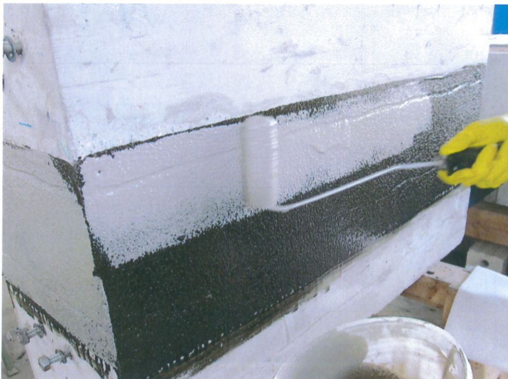
Bild 4 Auftrag von adicon® lamin DS/LF auf die Grundierung
