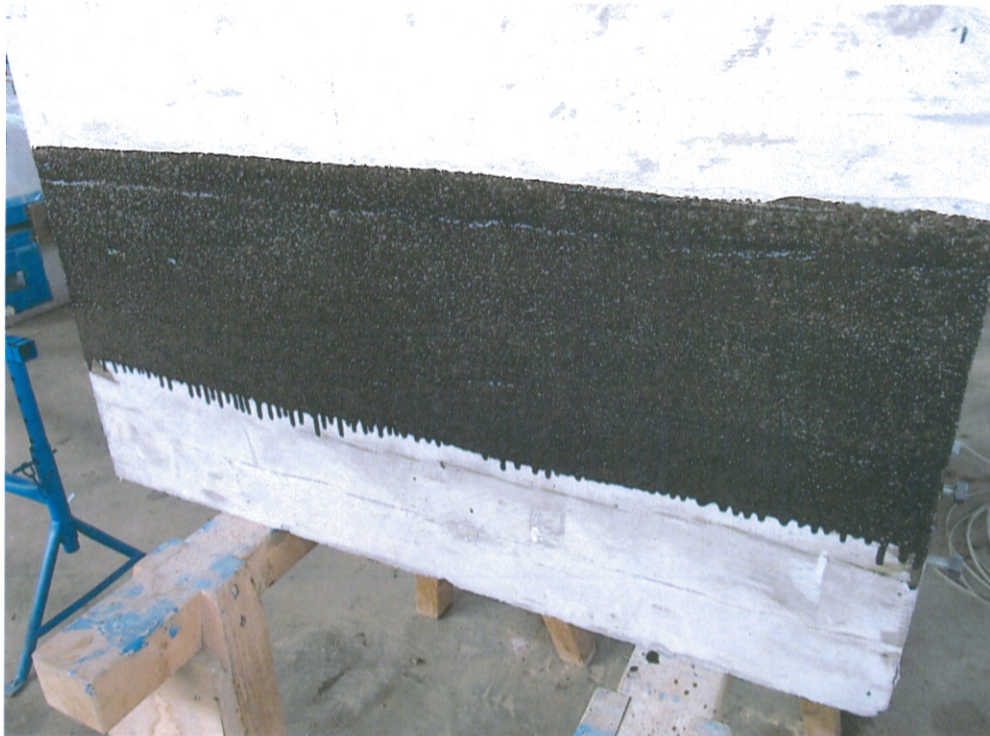
Bild 3 Grundierung nach dem Absanden
